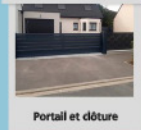
Portail et clôture
