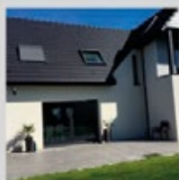
CONSTRUCTION de MAISON NEUVE
